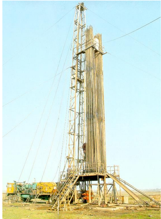
Слика 1. Торањ ремонтног постројења [2].
