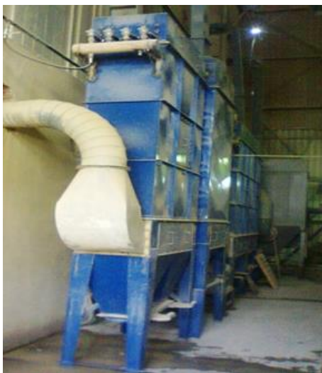
Slika 6. Spoljašnji izgled postrojenja
